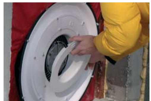
Fot. 4. Instalowanie blendy na wentylatorze urządzenia Blowerdoor
