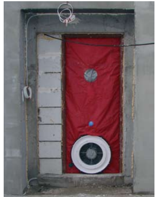
Fot. 2. Urządzenie Blowerdoor zamontowane w drzwiach. Próba na nadciśnienie – blendy od strony zewnętrznej
