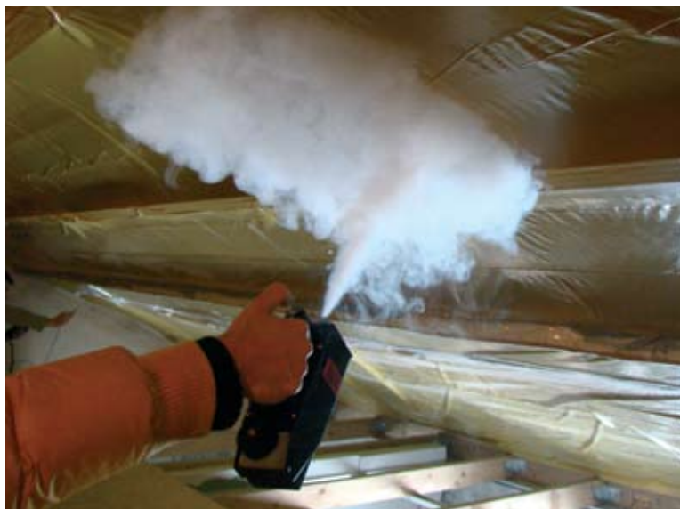
Fot. 5. Sprawdzanie szczelności poddasza za pomocą wytworzycy dymu. Na fotografii widać jak paroizolacja została docisnięta do termoizolacji podczas próby na nadciśnienie
